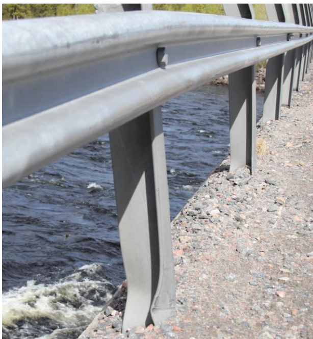
Figur 2a, 2b. Påkörnings-/plogskada på räckesståndare. Bucklad/böjd fläns. Jämför med intilliggande ståndare.
