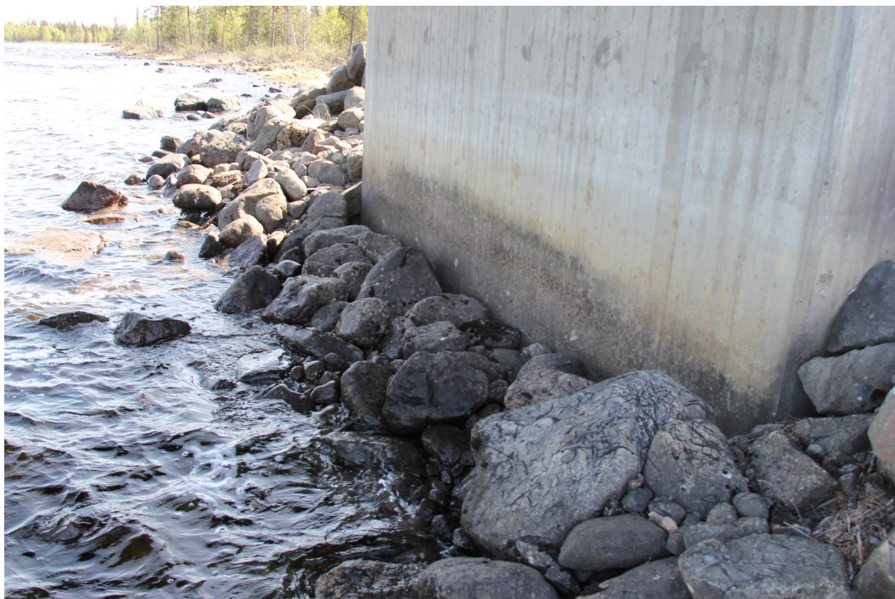
Figur 14. Södra landfästet, erosionsskydd framför frontmur.
