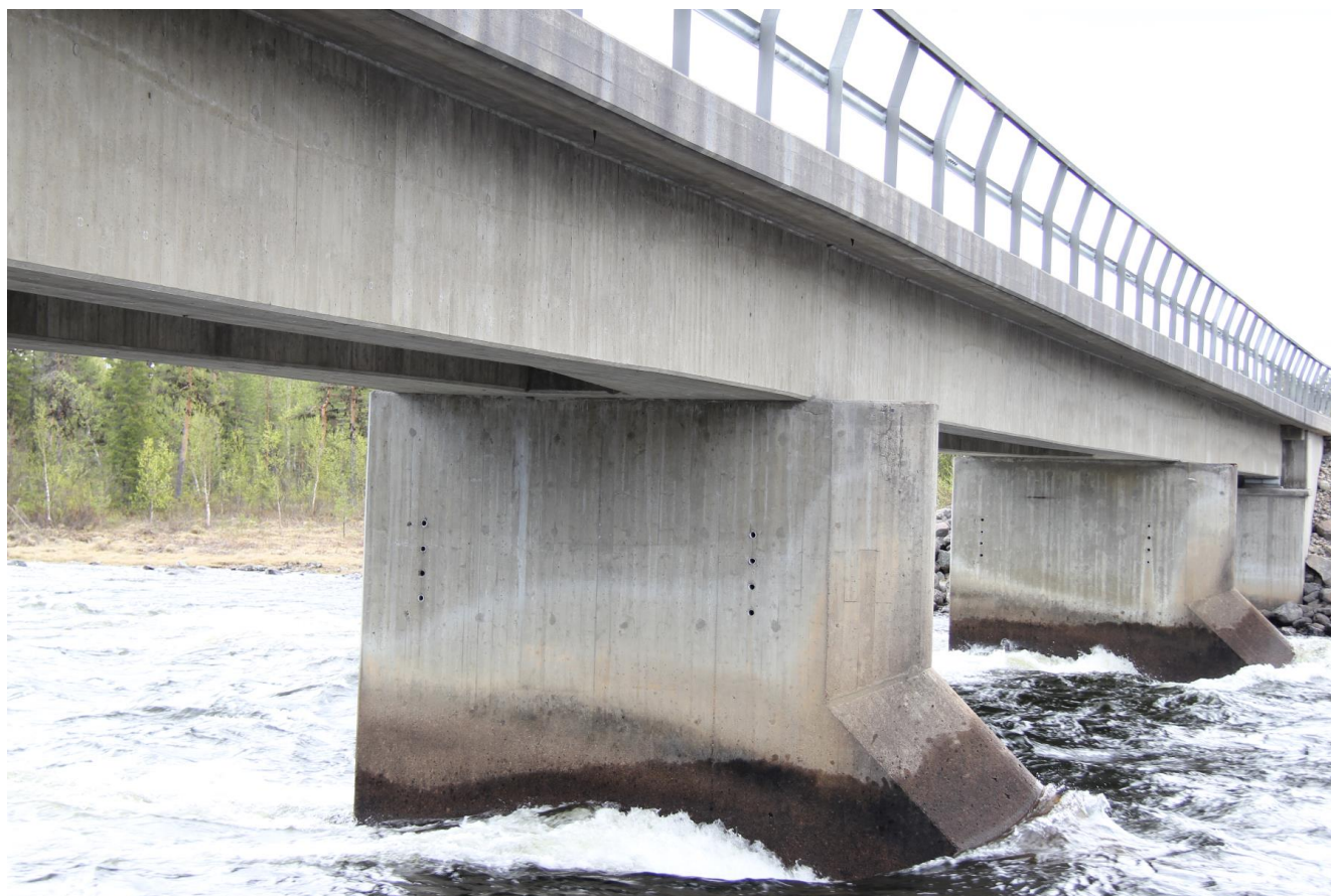
Figur 18. Mellanstöd med isbrytare
