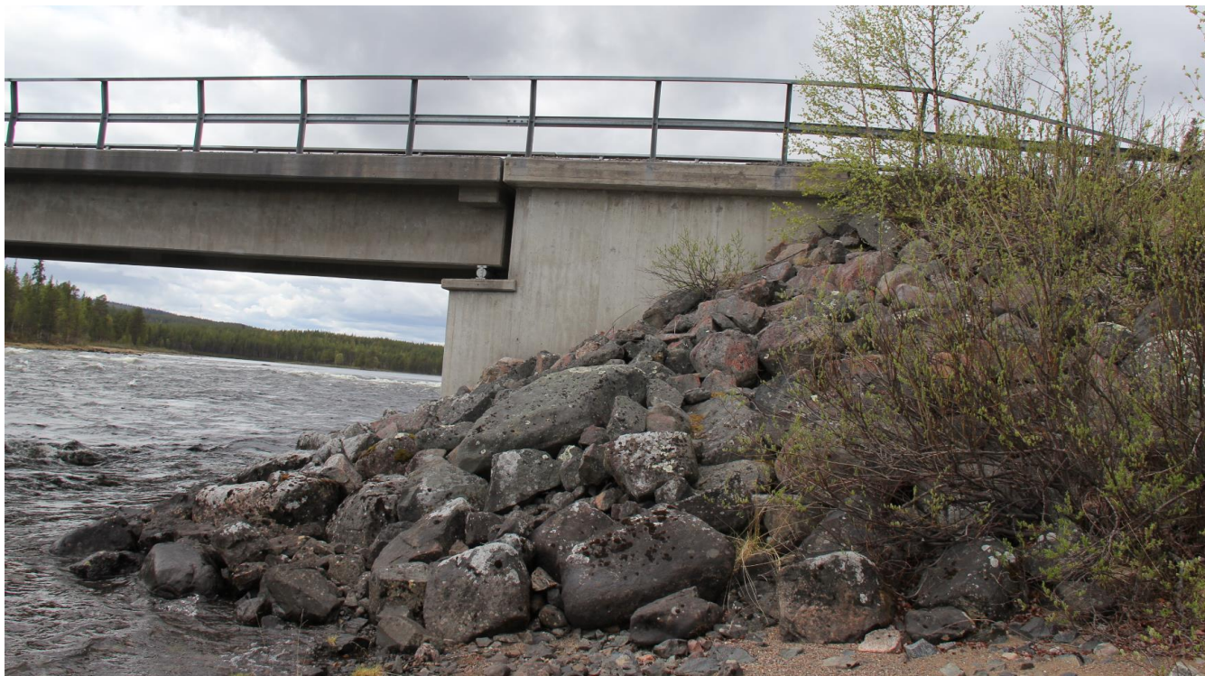
Figur 15. Norra landfästet, nordöstra brokonen.
