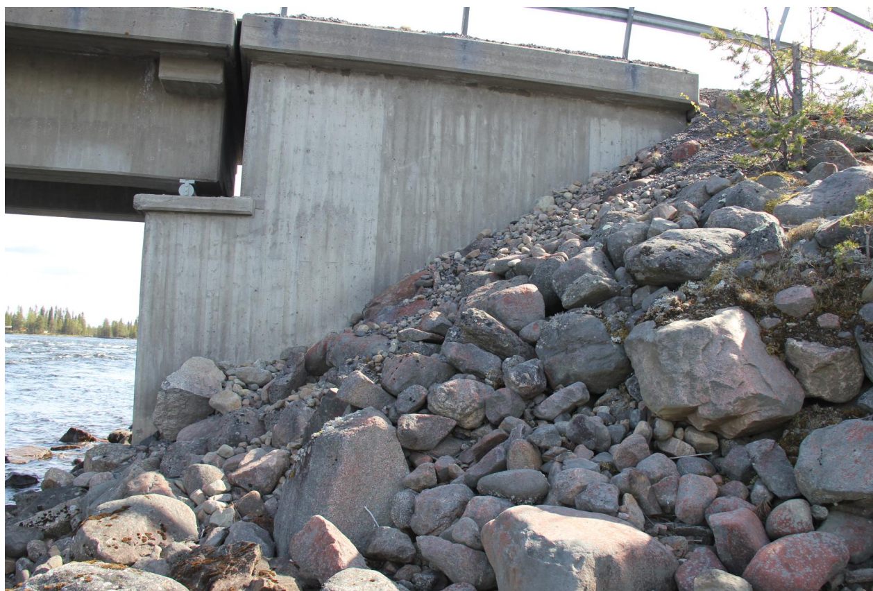
Figur 13. Södra landfästet, sydvästra brokonen.
