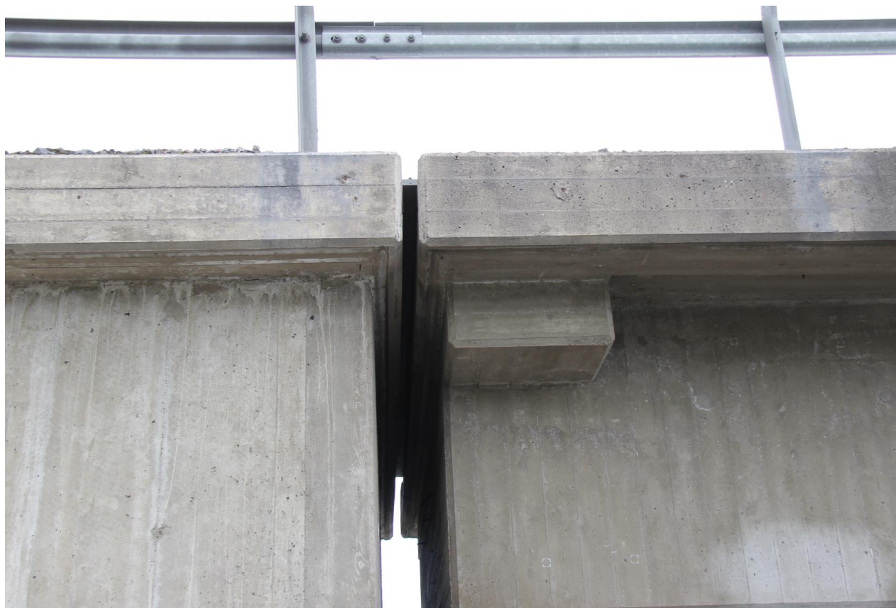
Figur 21. Detalj rörelsefog mellan broöverbyggnad och landfäste.
