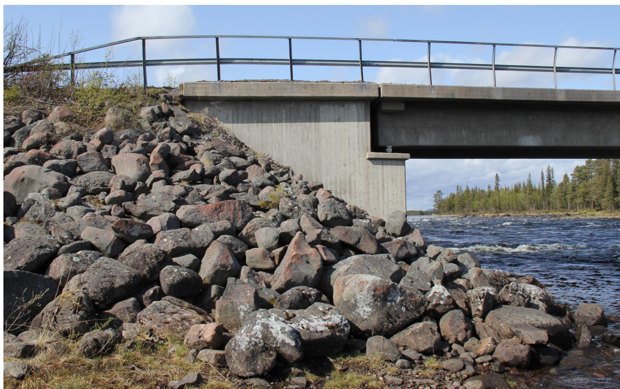
Figur 12. Södra landfästet, sydöstra brokonen.
