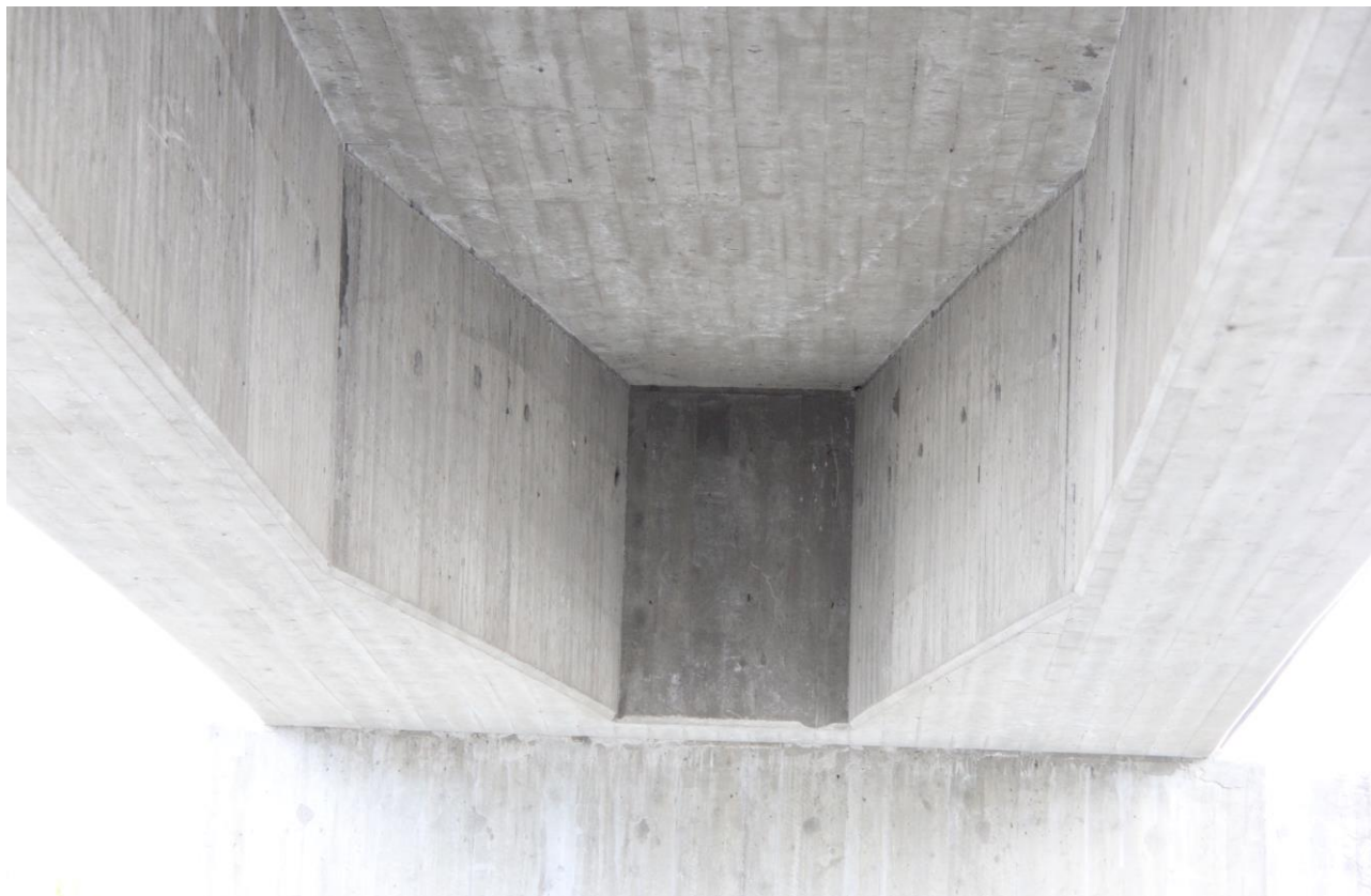
Figur 20. Detalj betongöverbyggnad vid mellanstöd. Betongytan i genomgående gott skick.
