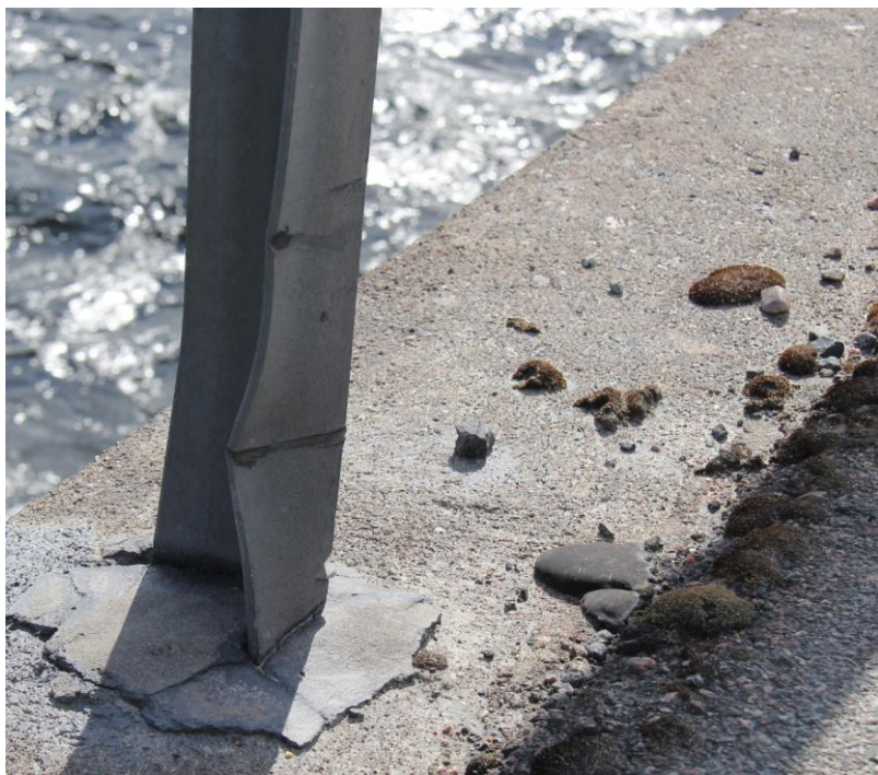
Figur 3a, 3b. Fler exempel på påkörnings-/plogskada på räckesståndare.
