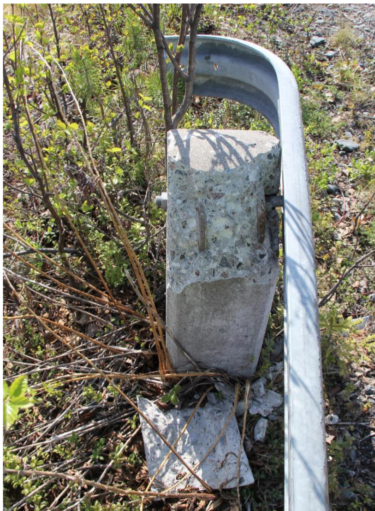
Figur 5a, 5b. Påkörningsskada på räckesavslutning, sydöstra sidan.
