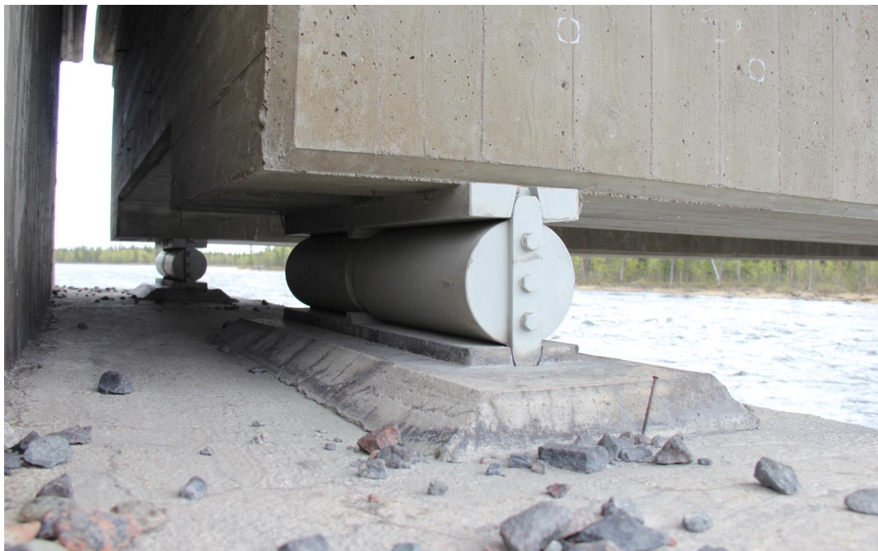
Figur 11. Brolager med undergjutningar genomgående i gott skick och med bedömd rätt förinställning.
