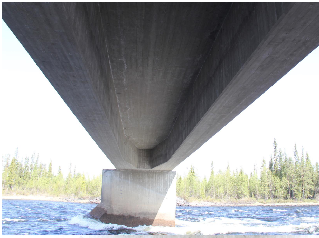
Figur 20. Betongöverbyggnad och mellanstöd.
