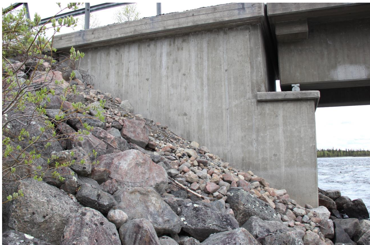
Figur 16. Norra landfästet, nordvästra brokonen.
