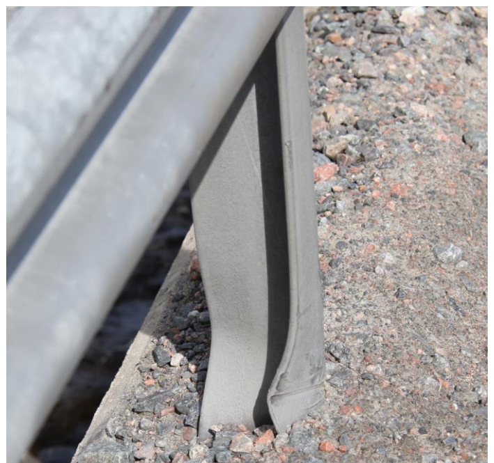
Figur 2a, 2b. Påkörnings-/plogskada på räckesståndare. Bucklad/böjd fläns. Jämför med intilliggande ståndare.
