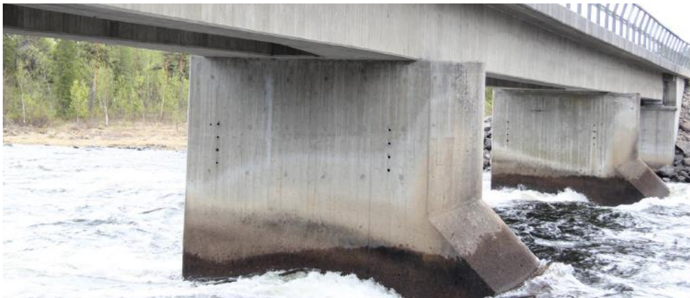
Figur 6 Skivstöd, urklipp från inspektionsrapporten.
