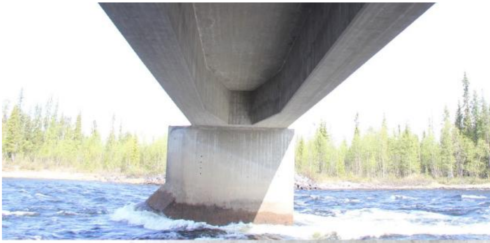
Figur 7 Huvudbalkarnas voter mot stöd, urklipp från inspektionsrapporten.
