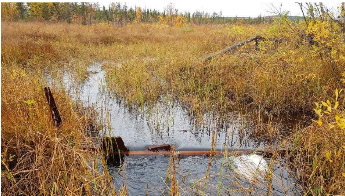
Figur 36. Damm vid myrens utlopp som använts för att reglera vattennivån i myren. Fotot taget i nordlig riktning
