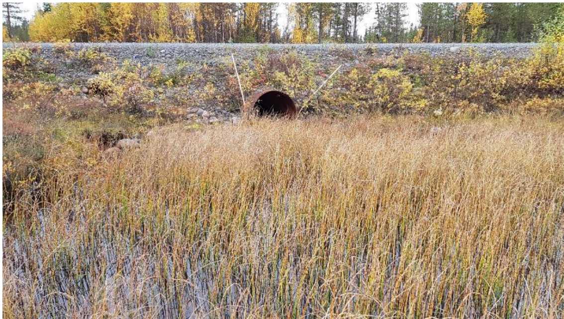
Figur 6. Myrens södra ände, där vattendraget rinner genom trumma under korsande väg. Fotot är taget i sydlig riktning och visar trummans inlopp.
