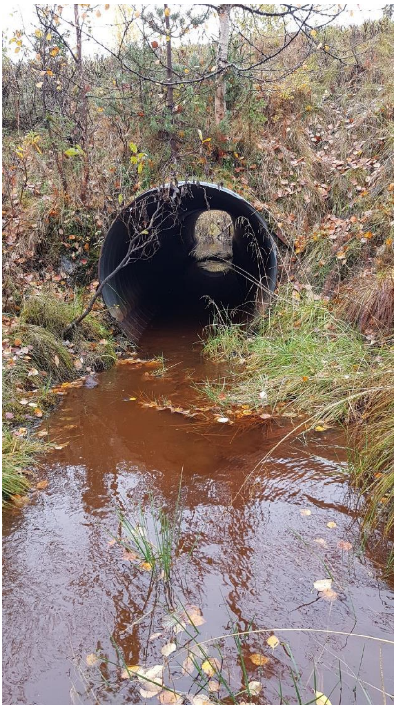
Figur 9. Korsande väg, trummans inlopp.
