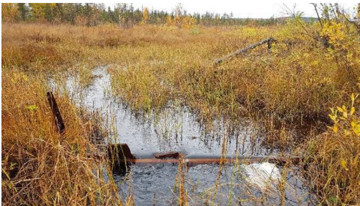
Figur 18. Fördämning 150 m uppströms bäckens mynning, vid myrens nedre gräns (lokal 15). Se bilaga 4 figur 36 för större format.
