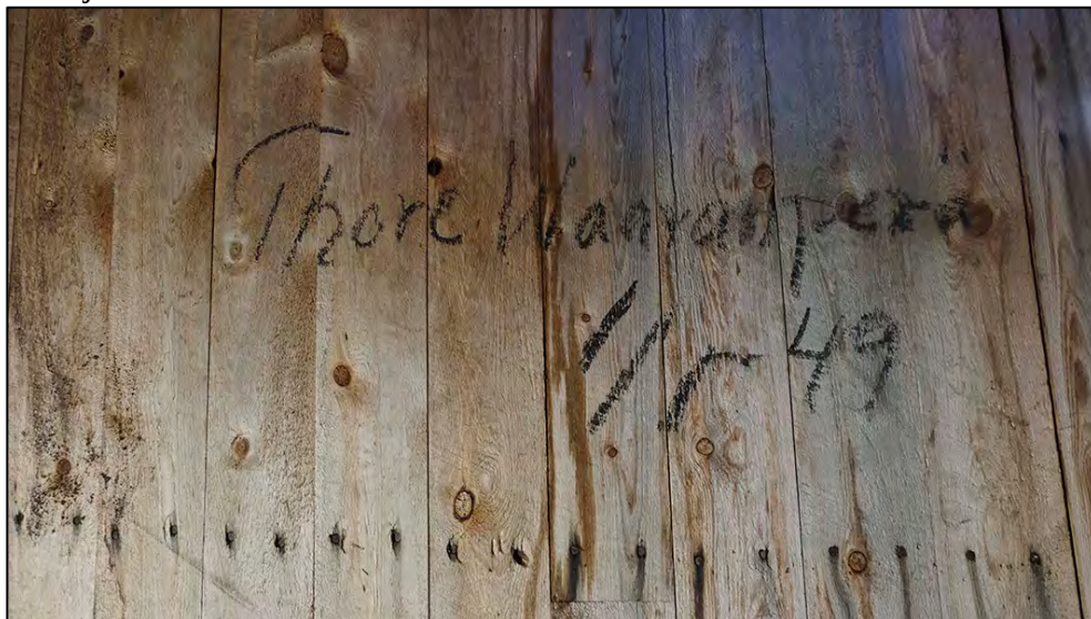
Figur 3. Inskriptionen "Thore Waaranperä 1/1 49" på en av innerväggarna i ID L2019:4134, antyder att kojan varit i bruk under sent 40-tal. Bilden är tagen från NV. Foto: Hanna Larsson © Norrbottens museum, acc nr. 2019_58_16.
