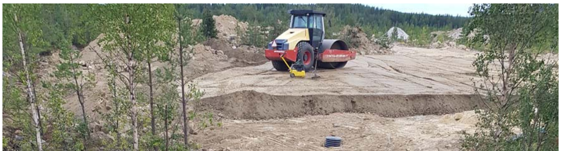
Figur 6: Bild av vibrovält från anläggande av testytor i annat projekt.
