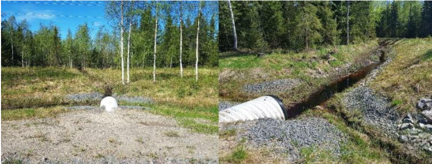
Figur 4. Befintlig trumma under Gräsörvägen (blå ring i Figur 3). Trumman har dimension 1000 mm. Avrinning via dessa trummor leds inte till Harrbäcken. Foton: AFRY 2020.
