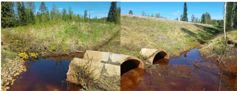
Figur 5. Befintliga trummor under Gräsörvägen (lila ring i Figur 3). Trummorna har dimension 800 mm. Avrinning via dessa trummor leds till Harrbäcken. Foton: AFRY 2020.
